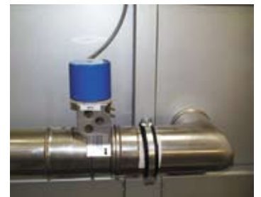
Kłapy nastawcze napędzane silnikiem
