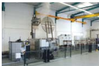
Wyjmowanie kosza załadunkowego z pieca do wyżarzania ujednorodniającego i transport do wanny wodnej
