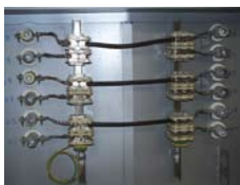
Połączenia elementów grzejnych w rozmieszczone pionowo sekcje grzewcze
