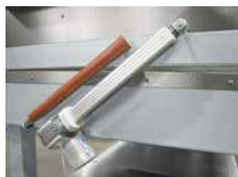
Automatyczne otwieranie kołpaka przy użyciu wrzeciona z napędem elektromechanicznym
